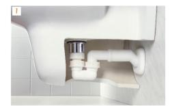
Nei sanitari sospesi, come nel caso di questo bidet, il sifone eccentrico permette di contenere lo sviiuppo delle tubazioni di scarico nell'altezza del sanitario, con un'ottima funzionalità del sifone stesso.
