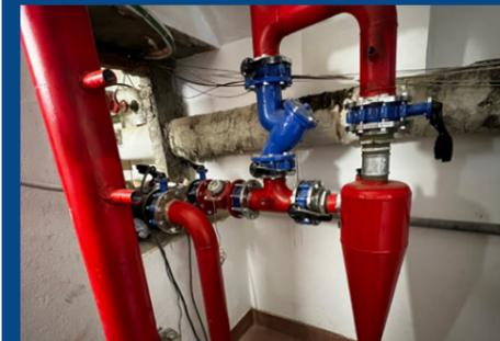
L'installazione di filtri ciclonici permette la rimozione delle particelle solide. ■ pag 45
